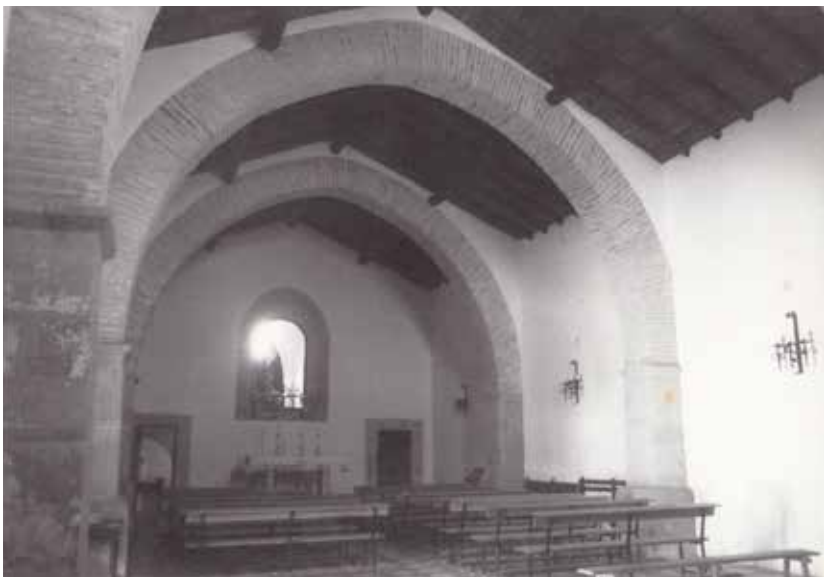
Fig. 2. Interior de la ermita de la Soledad una vez culminada la gran restauración de 1983-1984. Sencilla nave gótica de tradición mudéjar: arcos apuntados de ladrillo y armadura de madera a dos aguas. (Fuente: Fotografía cedida por Miguel Ruiz Calvente (1984))
